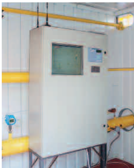
САУ ГРС на базе программно-технических средств, интегрированных в технологическое оборудование
